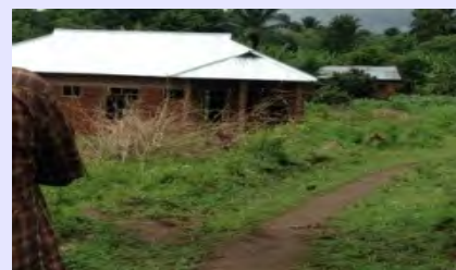
La casa in costruzione
